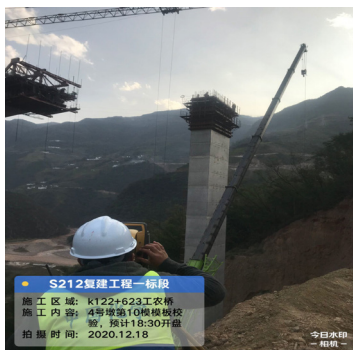
图2 桥墩偏位测量
